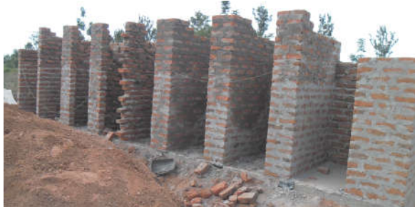
Das neue Toilettenhaus im Bau
