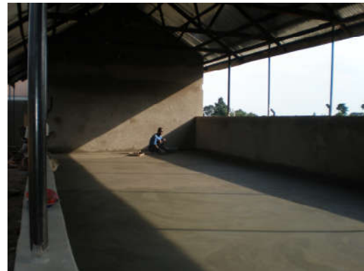
Der Boden im Speisesaal wird gemacht
