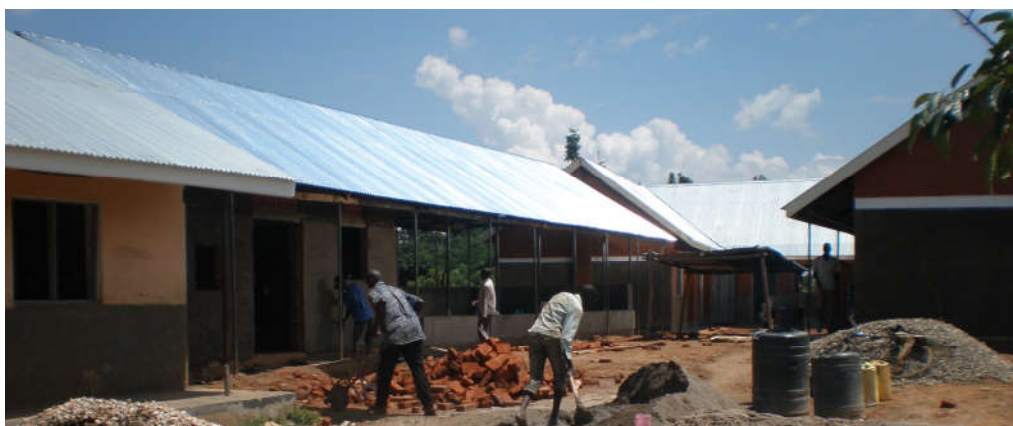
Neues Gebäude mit Küche, Lagerraum u. Speisesaal
