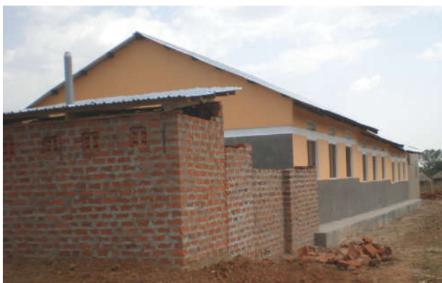
Hinterseite von Toilettenhaus und Hauptgebäude nach dem Streichen
