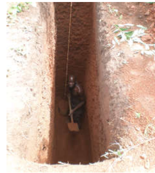
Graben für die Toilette
