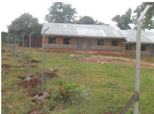
Die Zaunpfosten stehen
